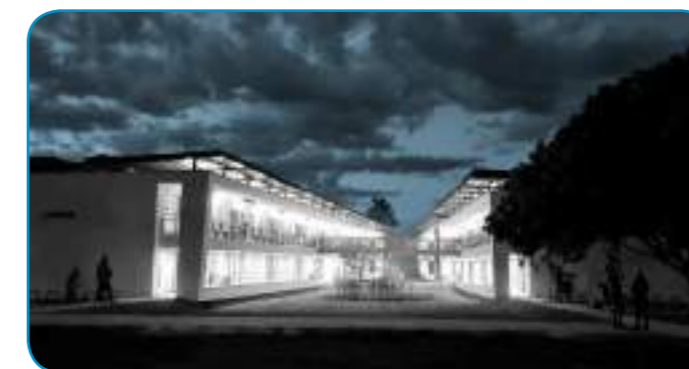
Foto noturna do novo alojamento (H8).
